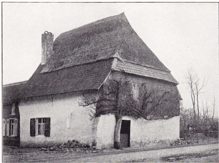
PEPINGHEN — Vieille maison à Kestergat (chaussée de Hal à Ninove)
